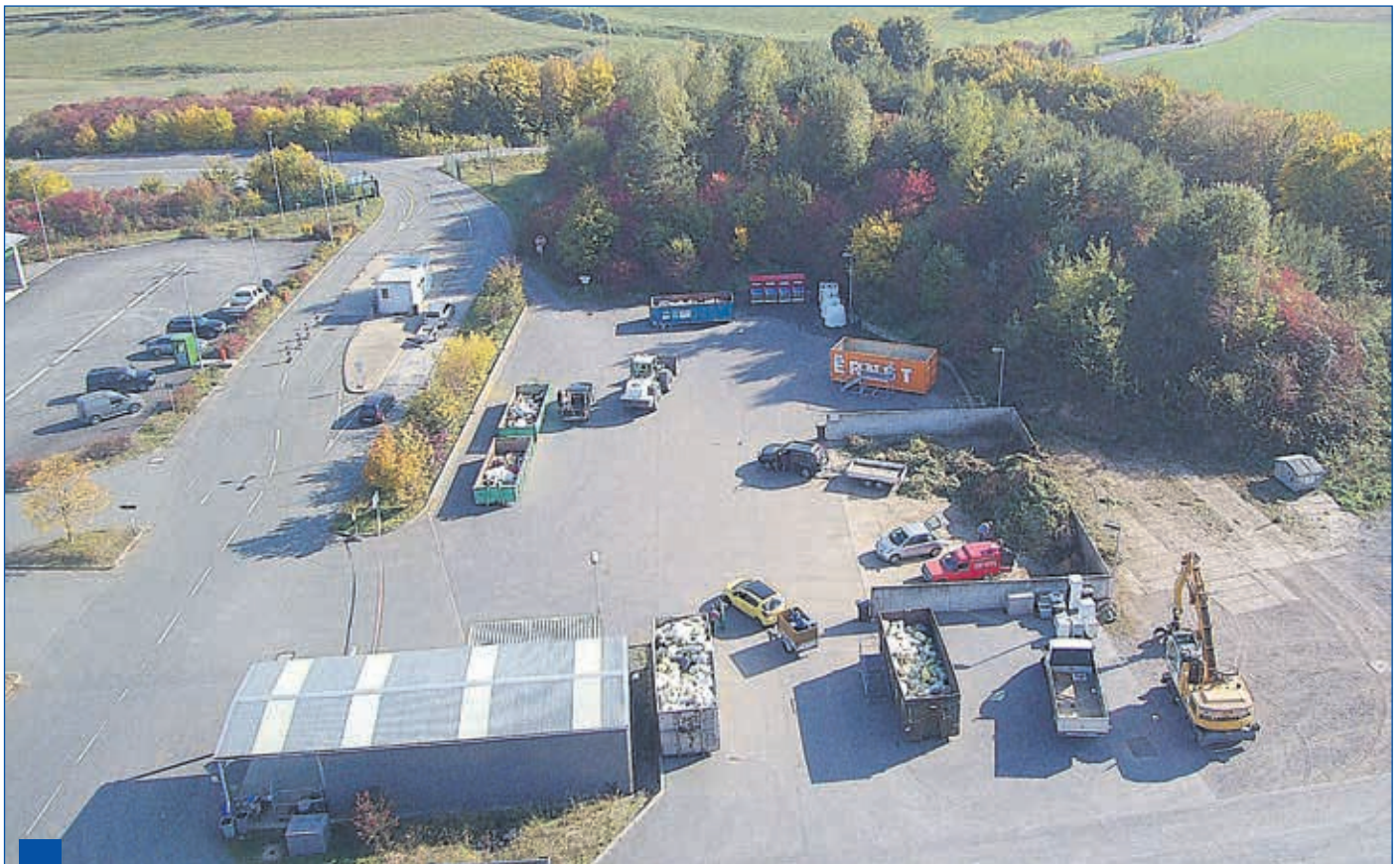
Wertstoffhof noch vor dem Umbau ohne separater Einfahrt
