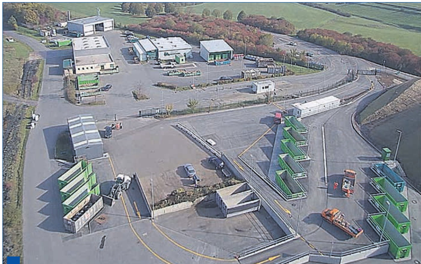
Wertstoffhof nach dem Umbau mit separater Ein- und Ausfahrt und Rampe (im Hintergrund ist der Kleinanliefererplatz, das Schadstofflager und Sozialgebäude des Abfallbehandlungszentrums zu sehen)
