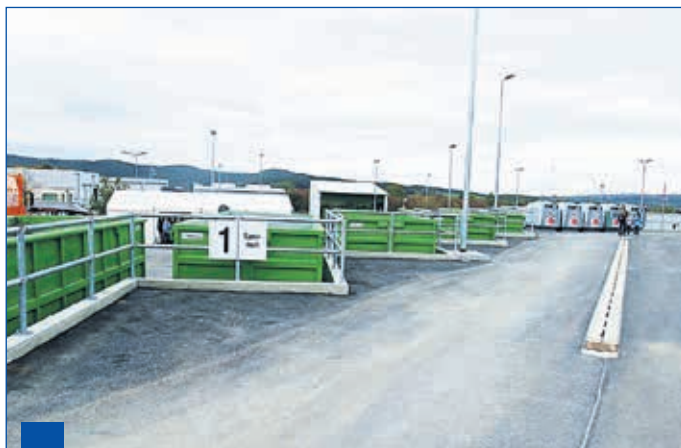
Rampe mit Ausfahrt
