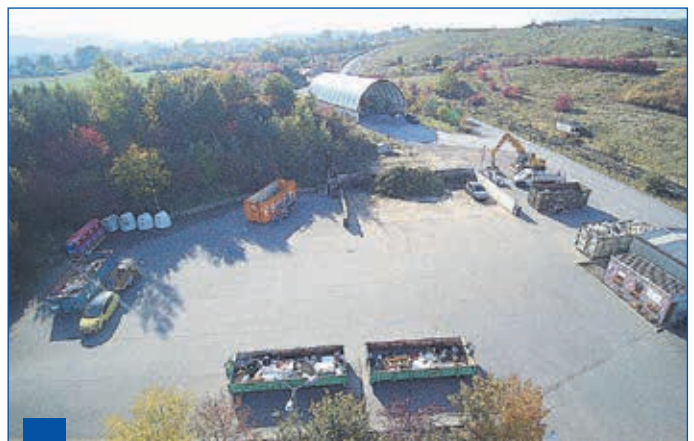
Wertstoffhof noch vor dem Umbau (ebenerdig, ohne Rampenanlage)
