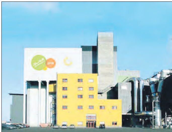
Die Müllverbrennungsanlage in Zorbau
