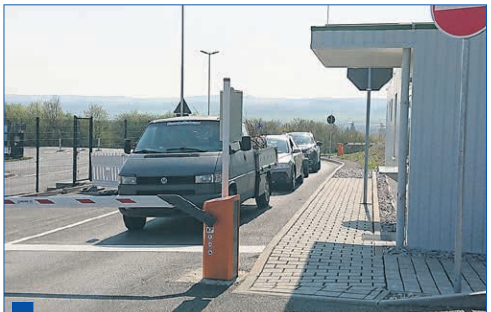
beschränkter Einfahrtbereich an dem Wertstoffhof Pößneck
