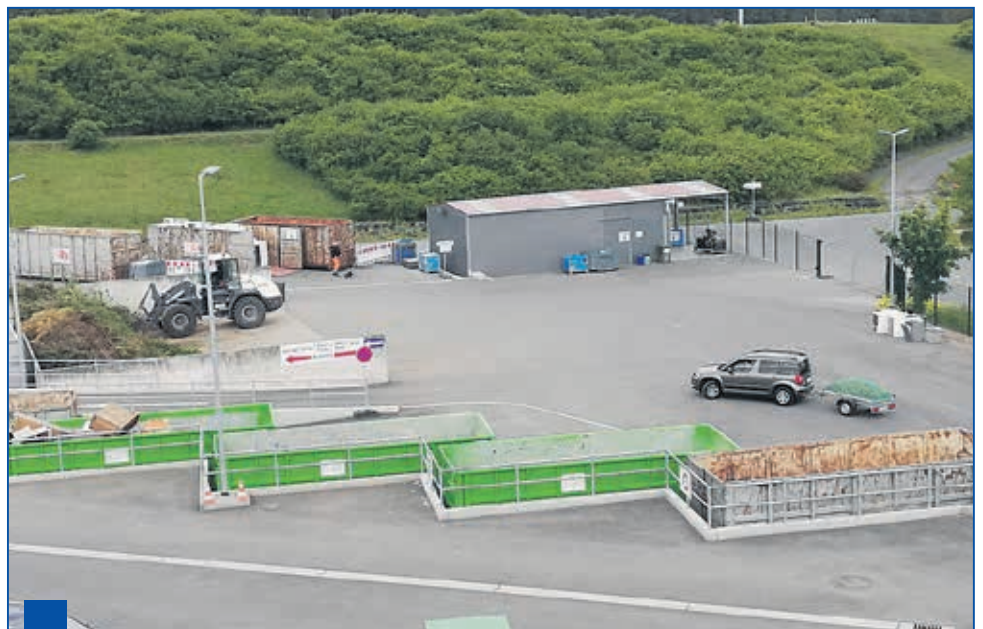
Wertstoffhof Pößneck nach Umbau (Mai 2020)
