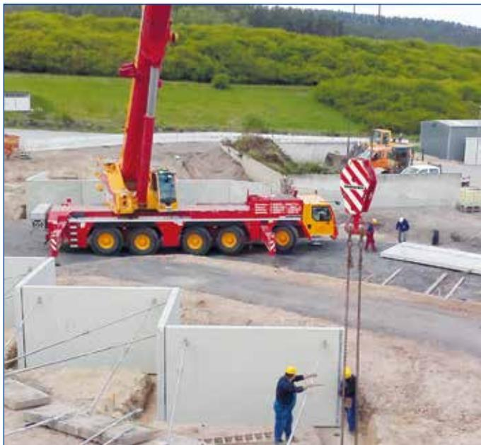
Aufbau der seitlichen Betonwände für die Containerstellplätze
