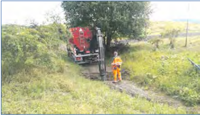
Einsatz Saugbagger zum Freilegen der zugespülten Gerinne
