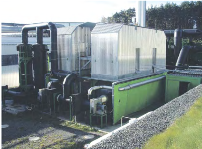
RTO zur thermischen Behandlung von Abluft aus der MBRA
