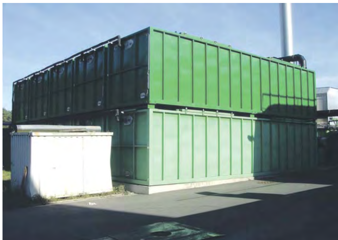
Blick auf die Biofilter
