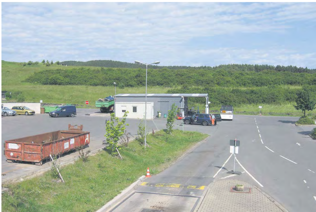
Eingangsbereich am ABZ Wiewärthe
