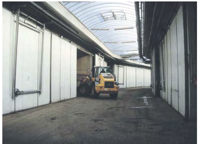
Blick in die Fahrgasse mit rechts und links angeordneten Rottetunneln
